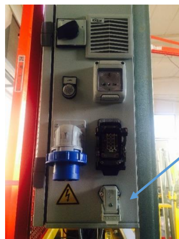
Рис. 2 – Разъем для подключения кнопочного пульта к главному щиту
